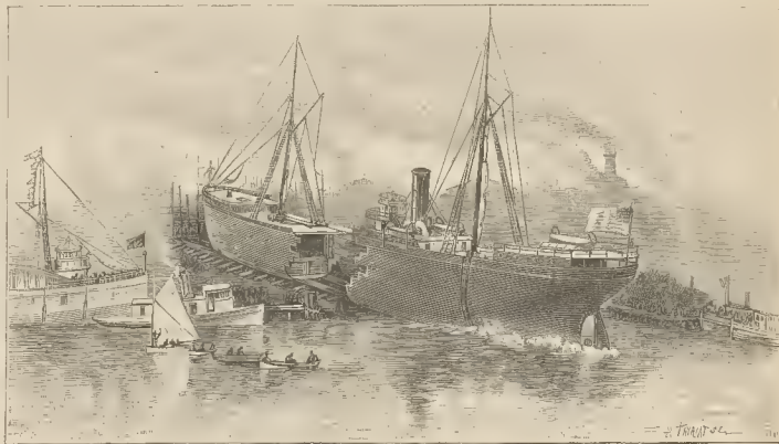
Fig. 1. Lanzamiento del buque americano divisible en dos mitades, en los astilleros de Buffalo
